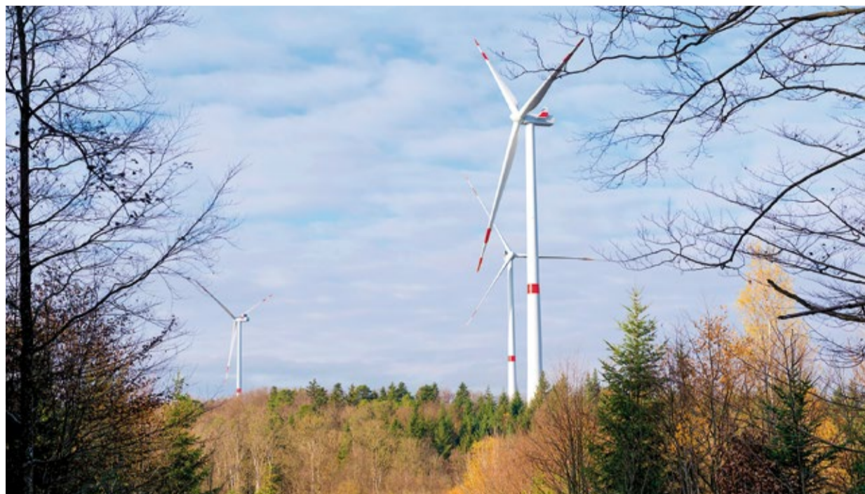
Windenergie lässt sich auch im Binnenland wirtschaftlich nutzen – wie hier an der Kohlenstraße.
