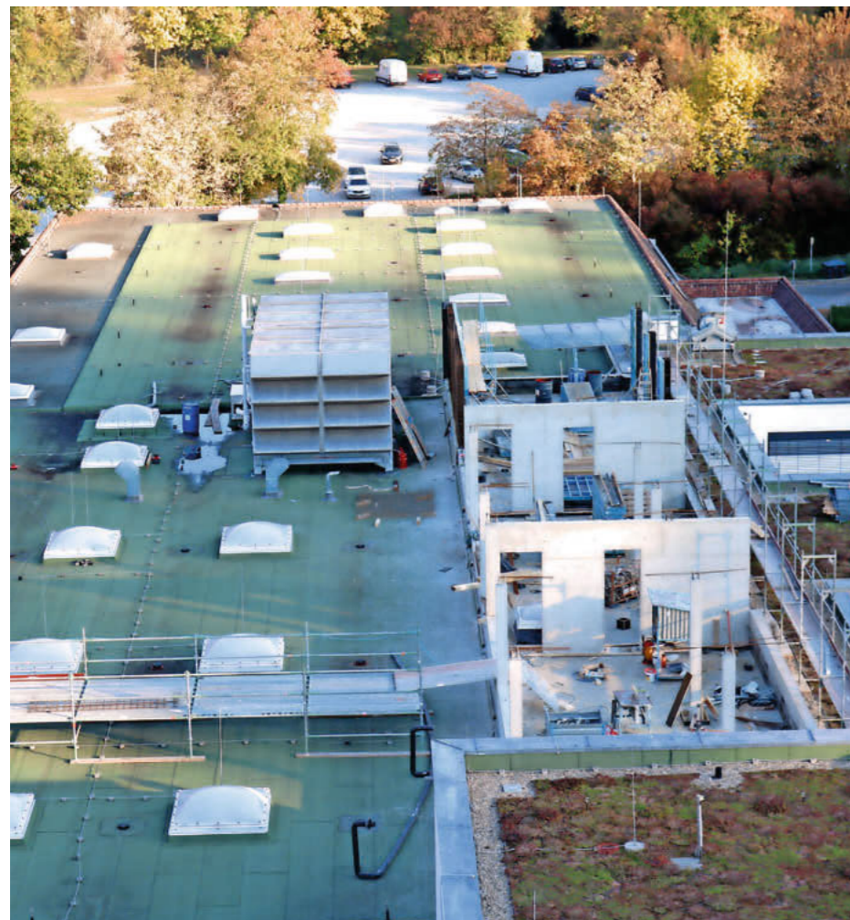
Für die Erweiterung des Standorts an der Steinbacher Straße muss die Fläche der ehemaligen Dachterrasse weichen. Diese wird aber an anderer Stelle neu angelegt.
