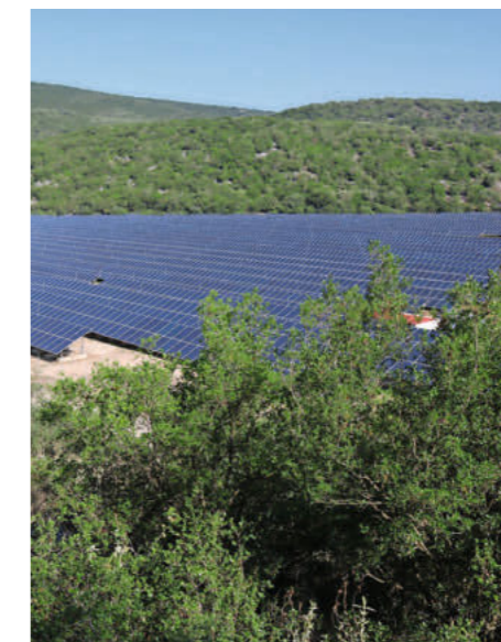
Beide Anlagen, in die die Solar Invest AG investiert haben, sind Freiflächenanlagen.
