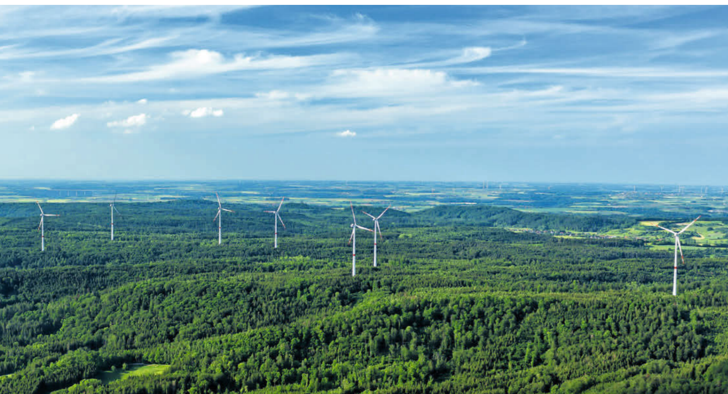
Der Windpark Kohlenstraße ist ein wichtiger Energieproduzent für die Stadtwerke Schwäbisch Hall. Die Anlage erzeugt jährlich rund 46 Millionen kWh Strom.
