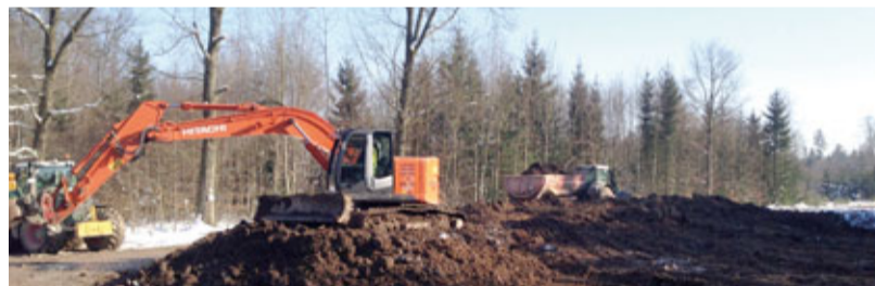
Die Erdarbeiten auf der Gemarkung Obersontheim gingen zügig voran.
