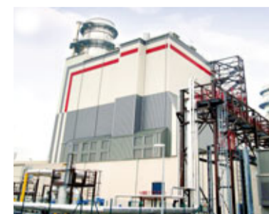
Erfolgreiches Projekt: das GuD-Kraftwerk in Hamm-Uentrop.
