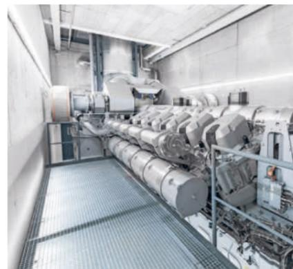
Aus eins mach zwei: Das Kraftwerk erhält einen weiteren Motor von MAN. Beide Aggregate bringen jeweils eine Leistung von 7,5 Megawatt.
