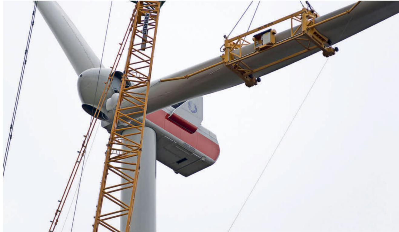
Montage der Rotorblätter im Zuge des Gondeltauschs: Ein Flügel der Windkraftanlage hat eine Länge von etwa 67 Metern.
