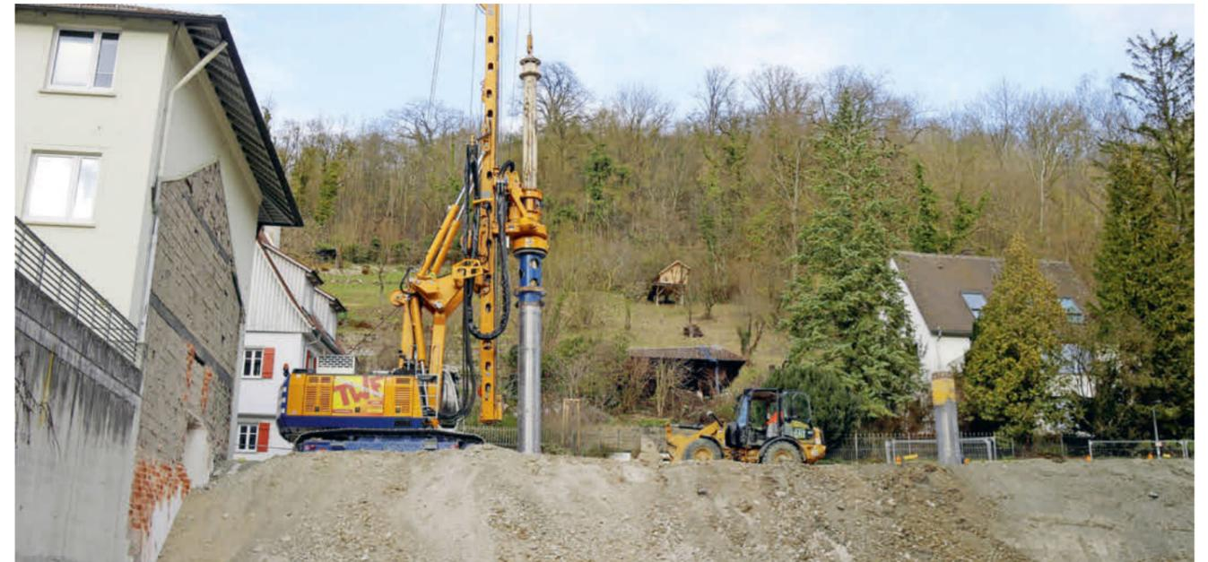
Zur Sicherung der späteren Baugrube dienen Bohrpfähle, die das große Bohrgerät herstellt.
