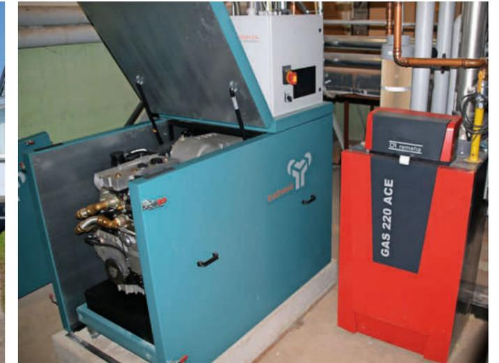
Im Heizungskeller der Grundschule von Rosengarten (links) befindet sich das Blockheizkraftwerk (rechts in Grün), das die Wärmeversorgung für die Schule und die angrenzenden Gebäude übernimmt.
