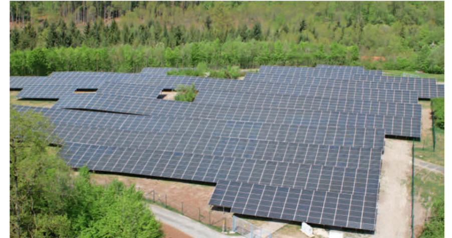
Die Freiflächen-Fotovoltaikanlage am Waldfriedhof besteht aus 2.380 Solarmodulen. Damit sollen pro Jahr etwa 800 MWh Strom erzeugt werden.
