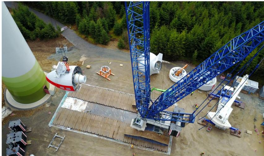
Eine unter dem Kran ausgelegte Folie schützt Boden und Wasser im Fall einer Havarie vor Verschmutzung.
