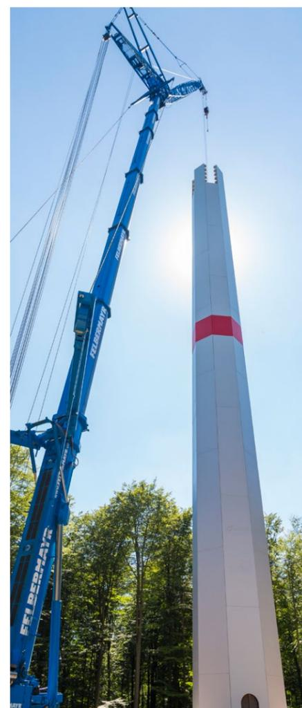
Die einzelnen Stahlbetonelemente werden vor Ort direkt vom Lastwagen aus zusammengebaut.
