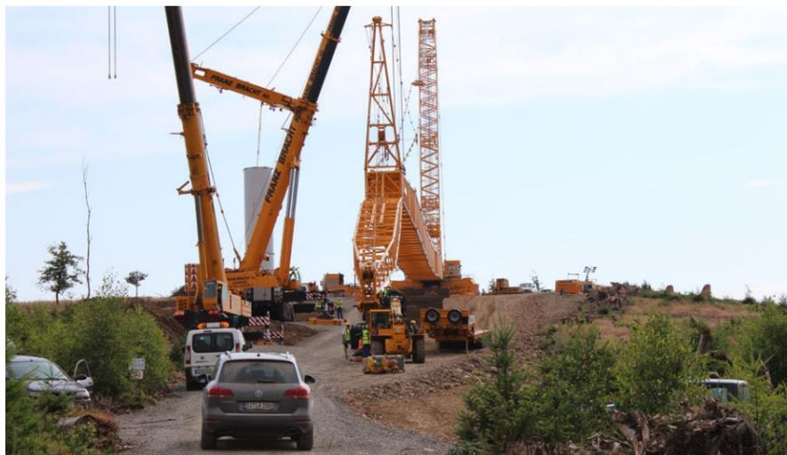
Stufenartig angeordnete Hilfskräne unterstützen bei der Errichtung des Krans.
