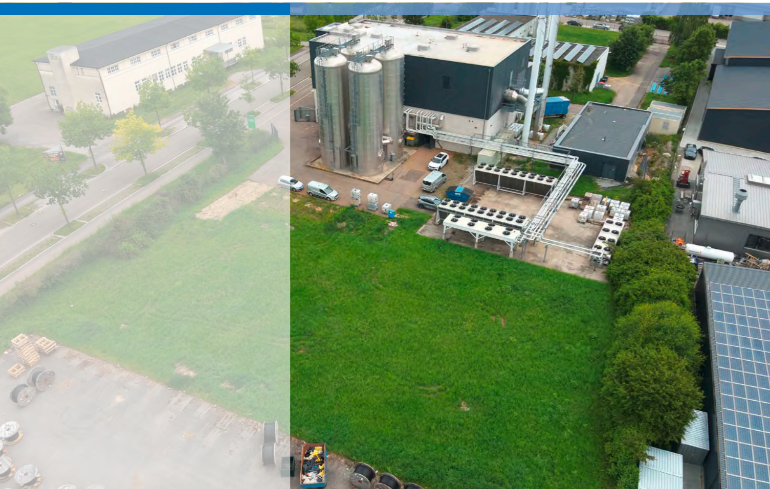
Foto unten: Auf der Wiese und auf Teilen der bisherigen Lagerfläche (unterer Bildrand) entsteht das Biomasseheizwerk am Kraftwerksstandort Hessental.
