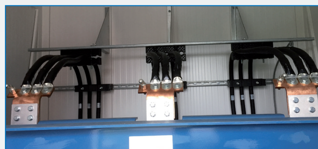
Transformator - Unterspannungsseite
