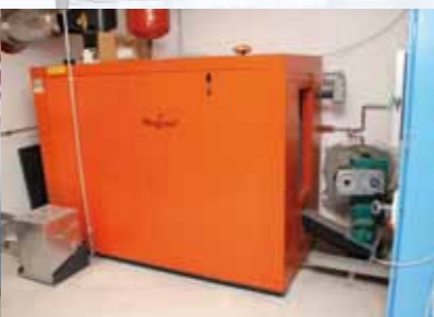
Hackschnitzelkessel
