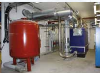
Blockheizkraftwerk (BHKW)
