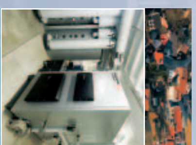
Nahwärmeverbund Bühlerzell: Aufbau und Betrieb eines Nahwärmeverbundes zur Versorgung eines Schulzentrums und vier weiteren Gebäuden mit einer 320-kW-Holzpelletheizung im Ortskern von Bühlerzell.
