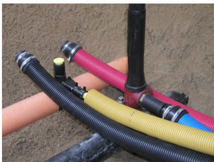
Beispiel eines Leerrohrgrabens Foto: Hauff-Technik
